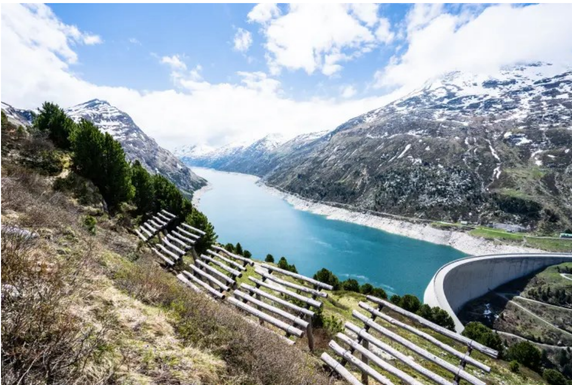
Die Staumauer am Lago di Lei.
